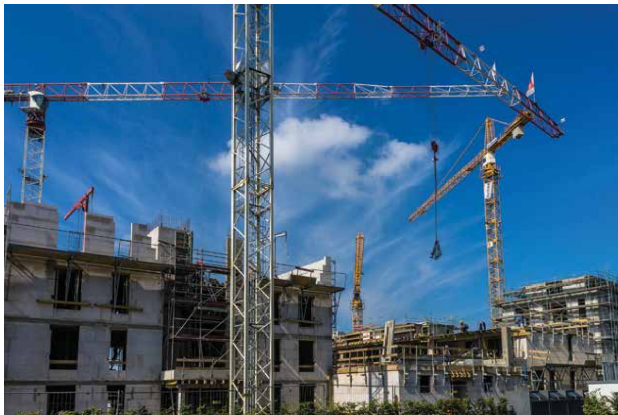
FIGURA 5. Construcción de la obra
