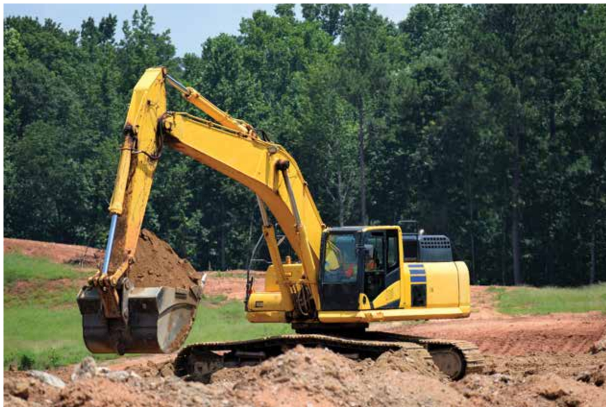
FIGURA 4. Acondicionamiento de terreno
